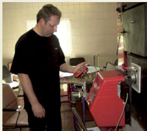
Рис.3 Монтаж и наладка параметров горелки
